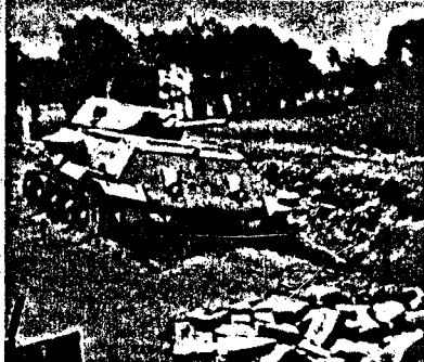
Frametter veien og ned i greften lå flere sønderkutte panservogner.
