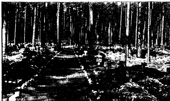
Gravlunden ved Jørstadmoen slik den var. Bildet er utlånt av Ole Rønning.
