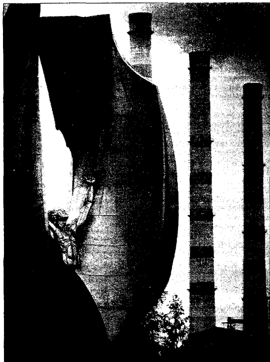
KRAFTVERK: Med sine to kraftverk som står for 95 prosent av Estlands energiproduksjon, er Narva en strategisk viktig by for esterne. Men særlig miljøvennlig er ikke Det baltiske kraftverk.
