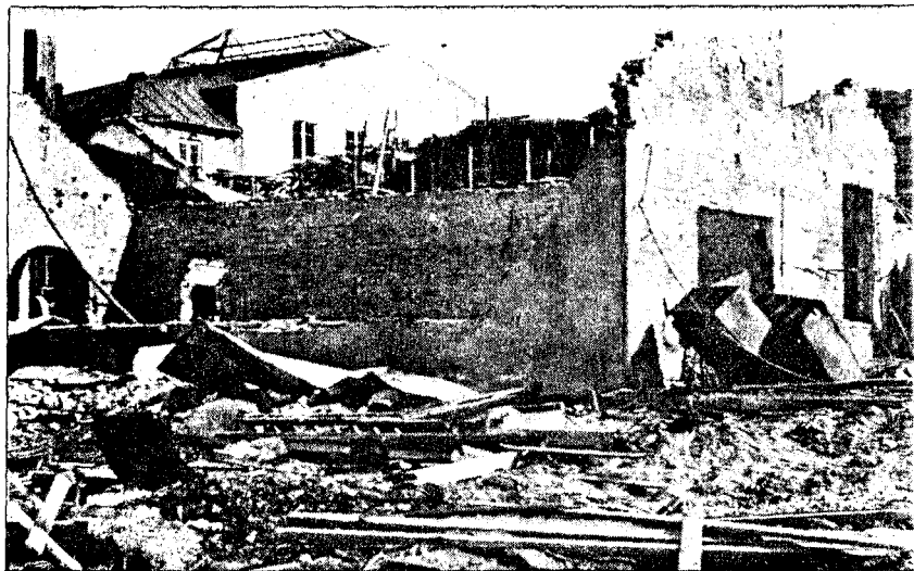
Flere hangarer og verkstedbygninger på Kjeller ble bombet om morgenen 9. april. Her fra motor- og plateverkstedet, som ble totalt ødelagt. (Foto: Oddvar Simonsen.)
