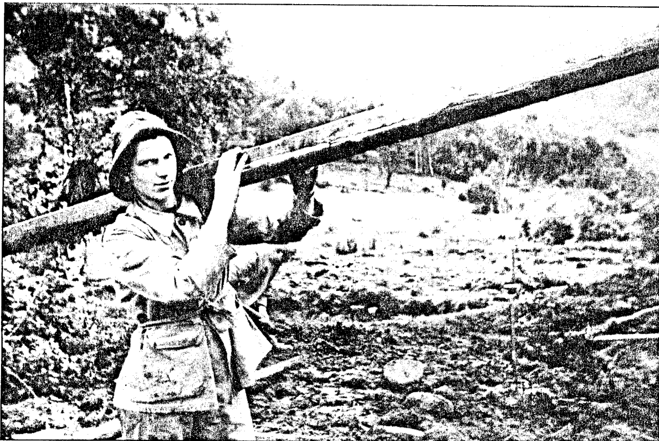
Trilleplankar blir lagt ut. Lyfting og bering vart grundig innøvd for å spare rygg og musklatur.
