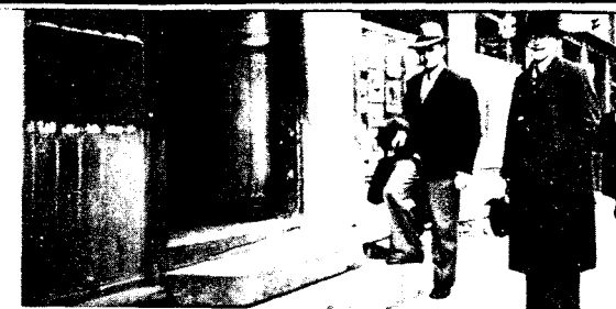
Her er det vel like før Christoffer Kobro (til høyre) stikker hodet inn på politikammeret og roper «Kobro» så det høres over syv prestegjeld. Eller iallfall så det høres av prester fra syv prestegjeld. Den andre som skal inn og melde seg for politiet, er Alv Askeland.
